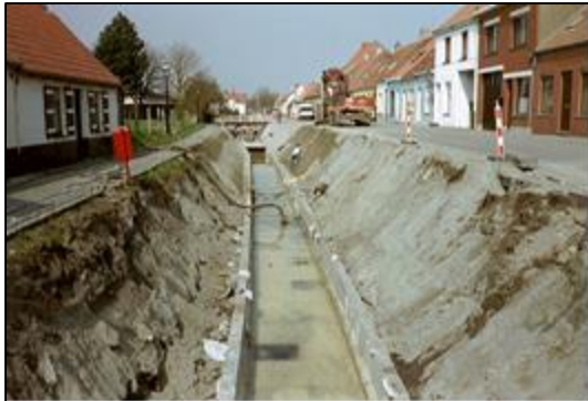
Foto: Herinrichting Lissewegse vaart t.h.v. Lissewege (U-profiel in de bodem).
