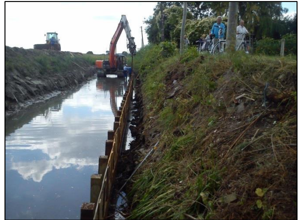
Foto: Plaatsen van de eikenhouten palen met hardhouten matten.
