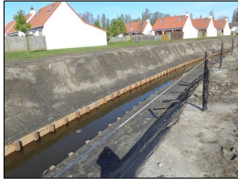
Foto: Oeverinrichting en buffer t.h.v. vakantiehuizen.
