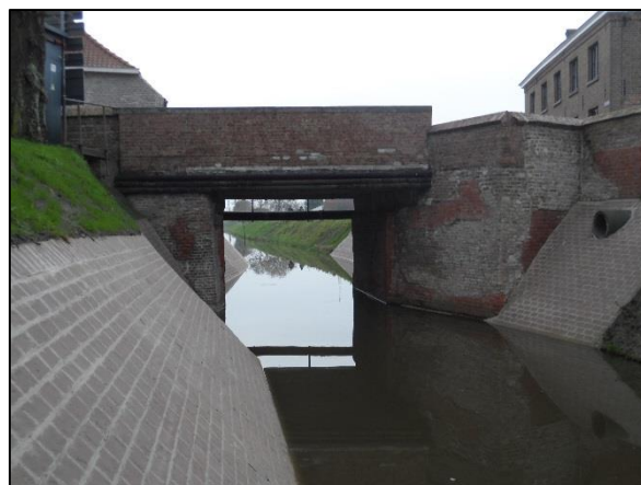
Foto: Herinrichting van de taluds en renovatie van De brug thv het dorp.
