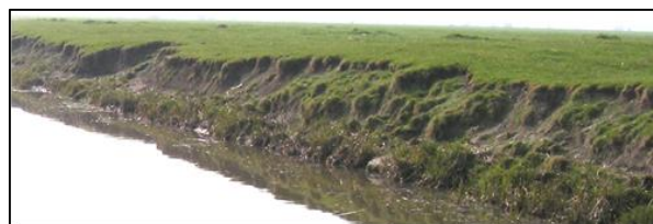
Foto: Detail sterke oeverafkalvingen stroomopwaarts aan de N9 Oostendsesteenweg.
