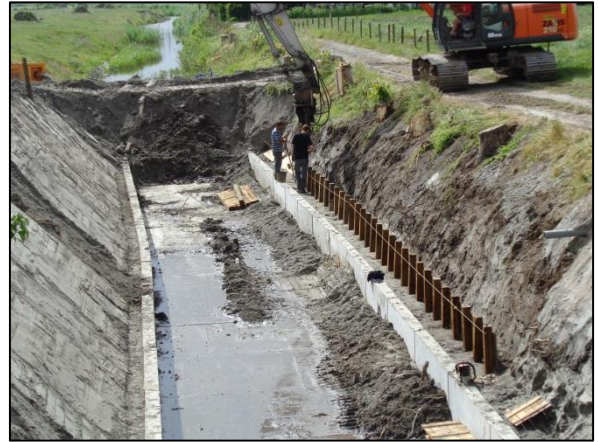
Foto: Plaatsen van de versterking t.h.v. de betonnen cunette.
