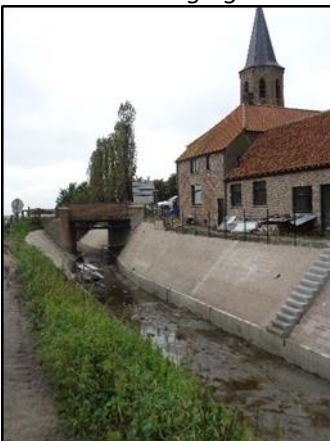
Foto: Oever en bodemversteving in aanleg t.h.v. Meetkerke dorp.
