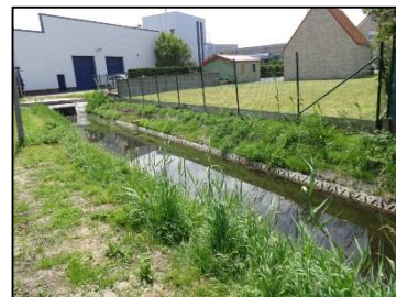
Foto: De oeverversterking op het Sint-Pietersmolengeleed werd herplaatst.
