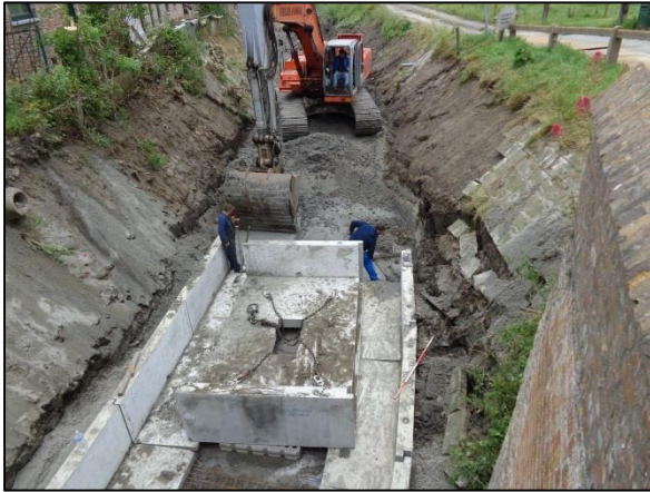
Foto: Plaatsen van de betonnen cunette.
