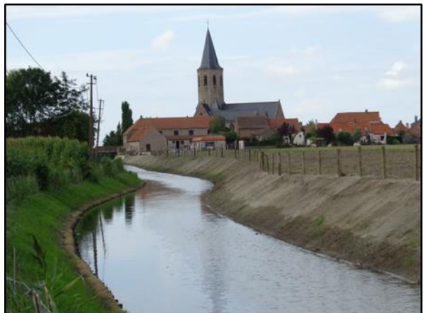
Foto: Afgewerkt deel natuurtechnische oeverversteving.
