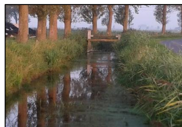
Foto: Waterloop en stuw na de herinrichting.
