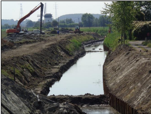
Foto: Voorbereiding plaatsen natuurtechnische Overversterking.
