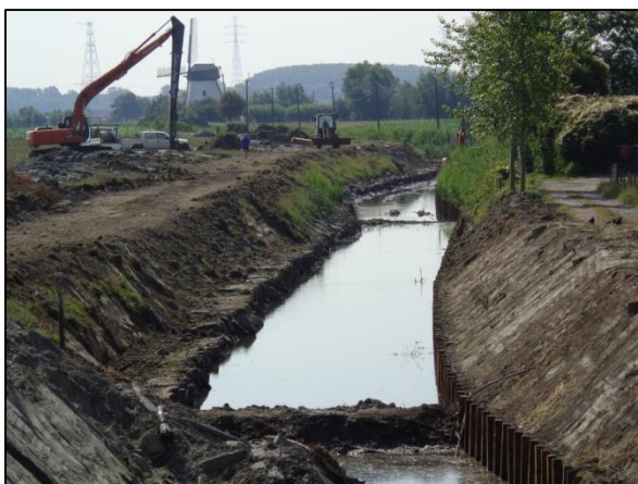
Foto: Voorbereiding plaatsen natuurtechnische Oeverversteving.
