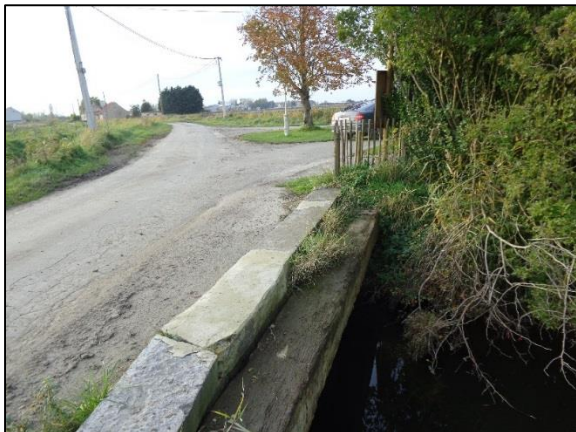
Foto: Herstel kopmuur B.1.7.
