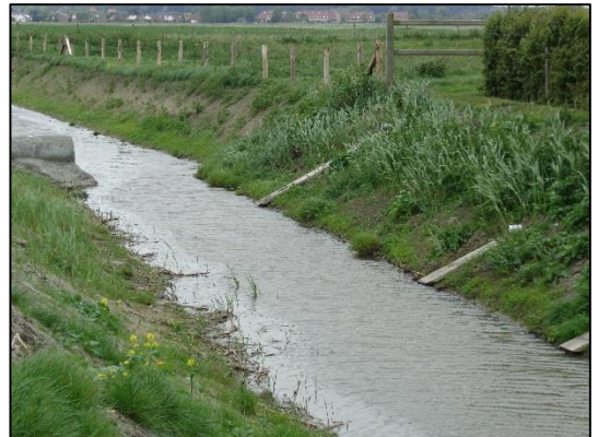
Foto: Overgang profiel C – D, afwerking van de afvoerbuizen.
