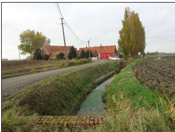
Foto: Het Blauwzwin ter hoogte van de Maereweg te Meetkerke na de werken.
