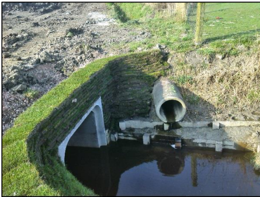
Foto: Perceelstoegang t.h.v. landslag uitgevoerd met kokers en afwerkt met blokszoden.
