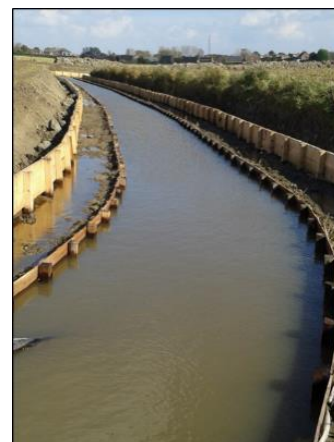
Foto: Bromzwin met bufferende functie.
