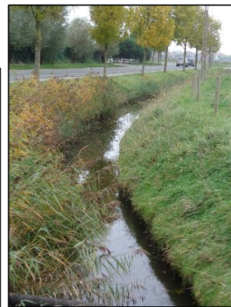
Foto: Dorpszwin na de werken, taluds reeds begroeid.
