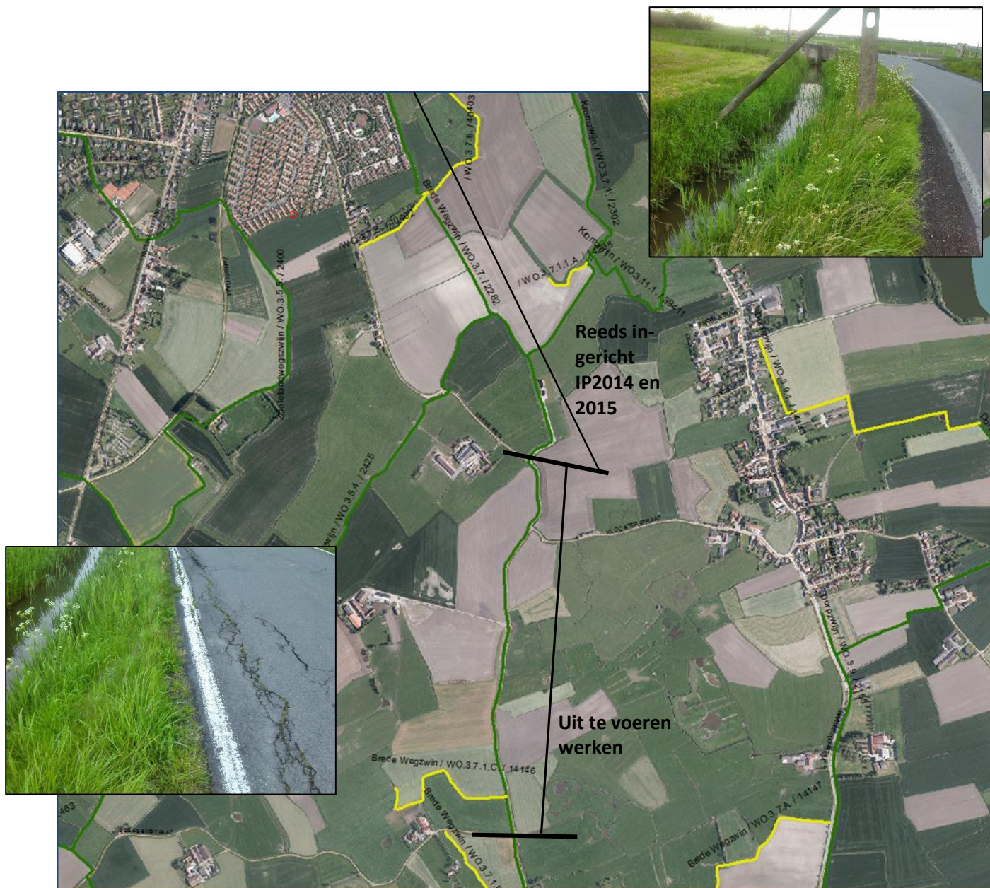
Figuur: Voorstel in te richten deel 2016, linker inzet: afgekalvde oevers, onveilige situatie bij kruisen van weggebruikers en onstabiliteit van de weg. Rechter inzet: gevaarlijke situatie voor openbare infrastructuur.
