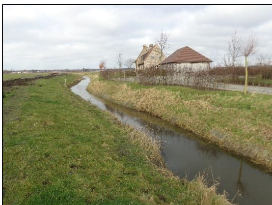
Foto: Het Bredewegzwin palend aan de toegangsweg naar de woning Bredeweg nr. 90 (Fase II).
