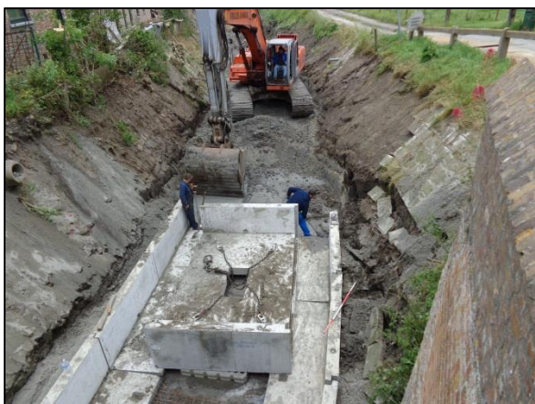
Foto: Plaatsen van de betonnen cunette.
