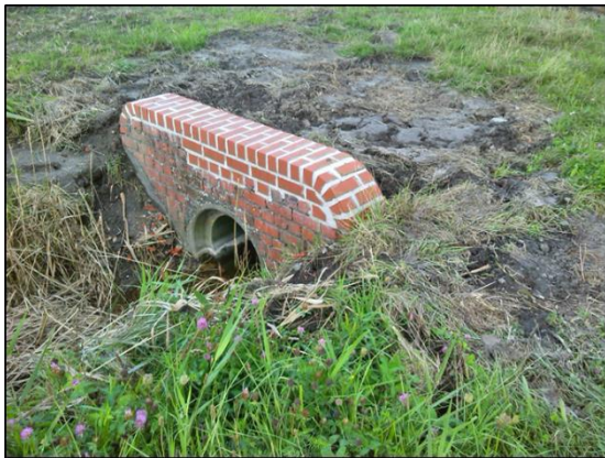
Foto: Herstelde kopmuur langs de Zandstraat.
