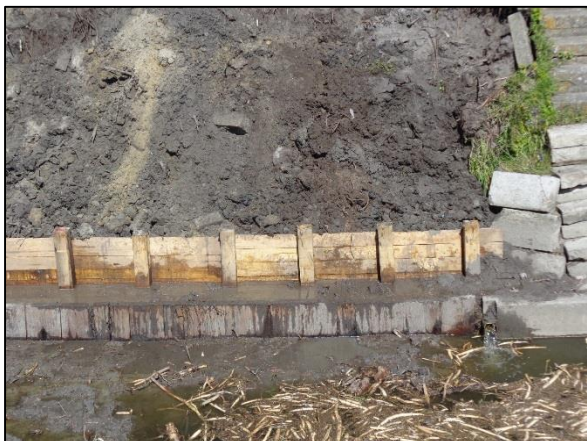
Foto: Wand met damplanken en 1 rij palen en hardhouten matten.
