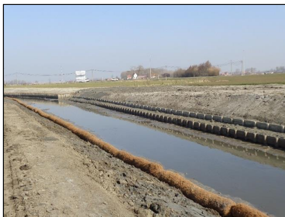
Foto: rechteroever ingericht met dubbele rij betuining, gescheiden door een plasbermzone.
