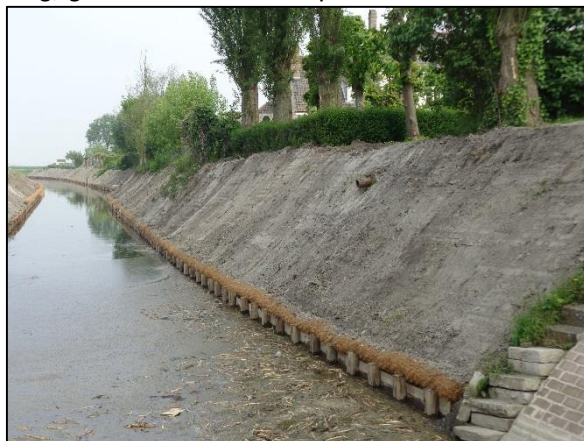
Foto: Blankenbergse vaart thv het kerkhof van Meetkerke, in afwerkingsfase.
