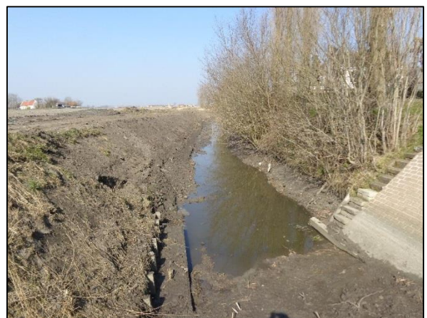
Foto: Overgang deel 1 – deel 2, bij de start van de werken deel 2.
