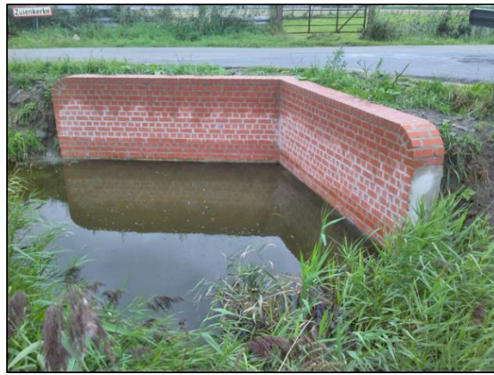
Foto: Herbouw kopmuur.
