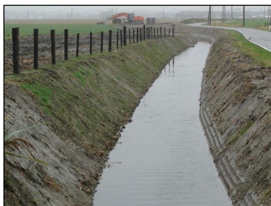
Figuur 13: Waterloop O.3.7.: kant van de weg: rietgels + zijde weiland: palen en planken
