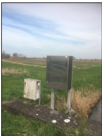
Figuur 39: Vervangen van een bestaande meetkast.
