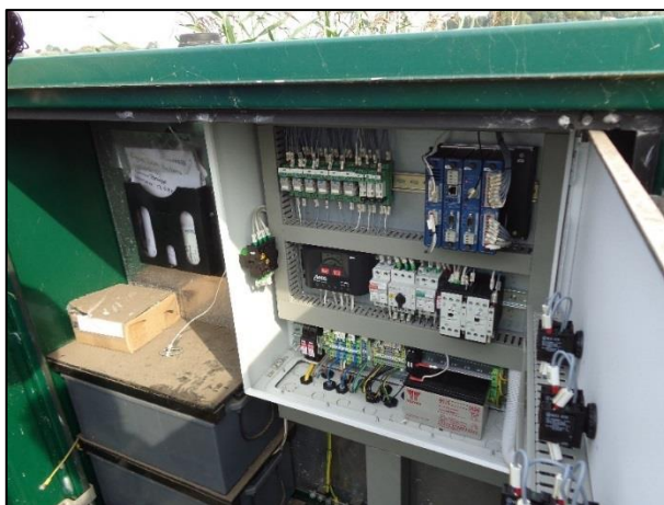
Figuur 40: Plaatsen van een meetkast in de bestaande kast van de stuw 'Moerzwin' en plaatsen van nieuwe batterijen.
