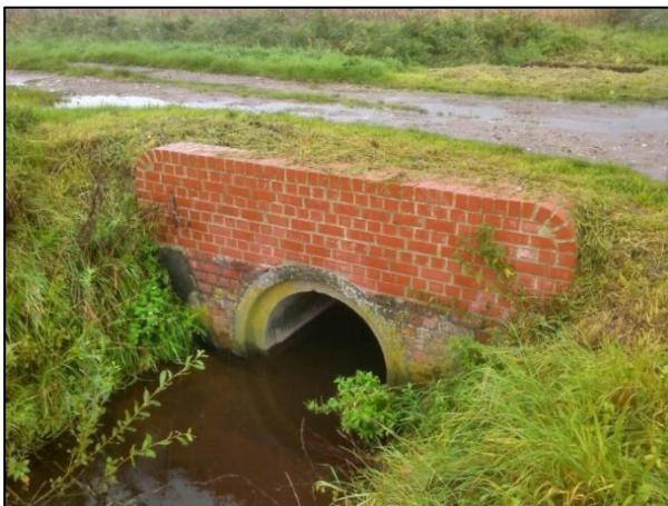
Figuur 20: Kopmuur hersteld in 2016.
