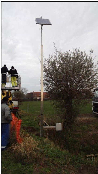
Figuur 36: Plaatsen van een nieuw meetpunt (P8).
