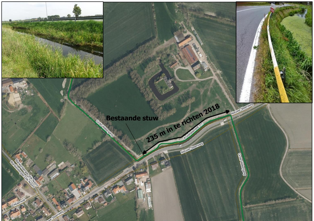
Figuur 26: Waterloop nr. B.1.7. voorstel in te richten deel 2018, inzet (2x): steile oevers aan de kant van de weg leiden tot onstabiele situatie voor de weg en de infrastructuur.
