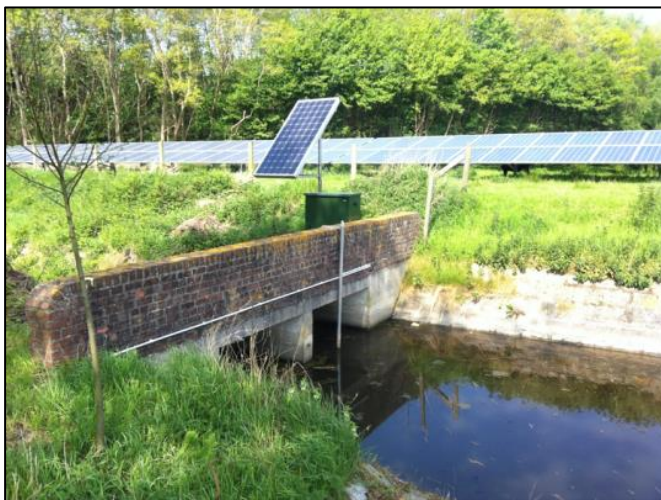
Figuur 28: Een bestaande meetinstallatie die aangepast wordt.
