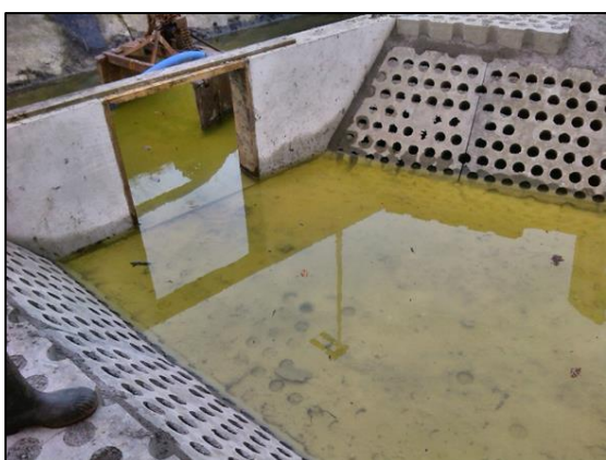
Figuur 23: Nieuwe stuw te Jabbeke met inrichting van de in- en uitstroom.
