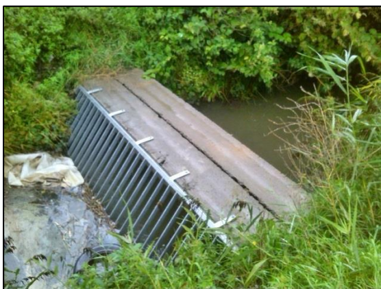
Figuur 21: Rooster om het vuil tegen te houden.
