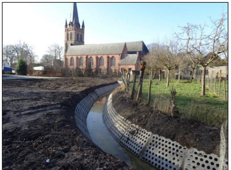
Figuur 18: Inrichting Oude Kerkebeek met drainerende betonstenen.
