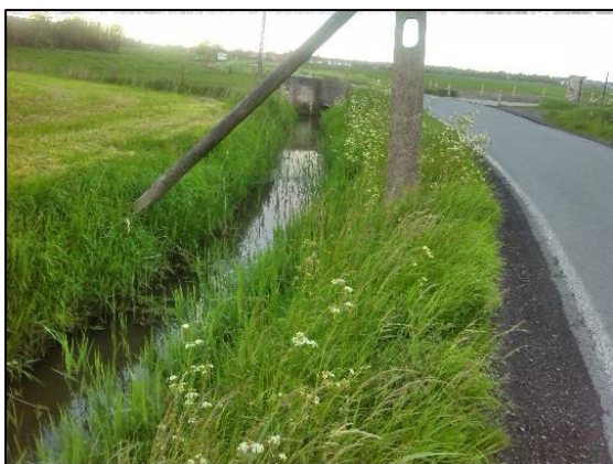
Figuur 10: Vóór de werken: gevaarlijke situatie voor de openbare infrastructuur.
