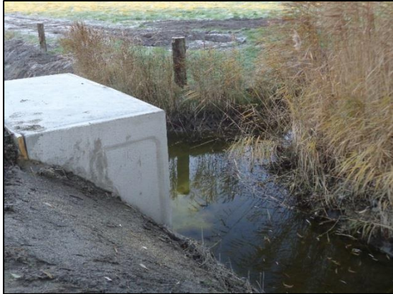
Figuur 16: Sokkel voor het plaatsen van een limnigraaf.
