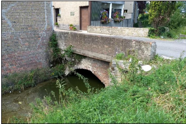
Figuur 17: De brug over waterloop nr. WO.3A.2. die toegang biedt tot de hoeve met als adres Plassendalesteenweg 4 te Bredene.
