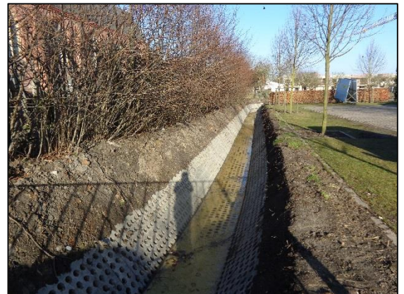
Figuur 20: Inrichting Oude Kerkebeek met drainerende betonstenen.
