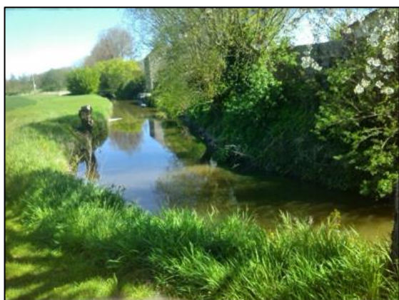
Figuur 9: Vóór de werken: gevaarlijke situatie voor de openbare infrastructuur.
