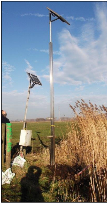
Figuur 30: Plaatsen van een nieuw meetpunt (P8).
