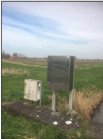
Figuur 31: Vervangen van een bestaande meetkast.
