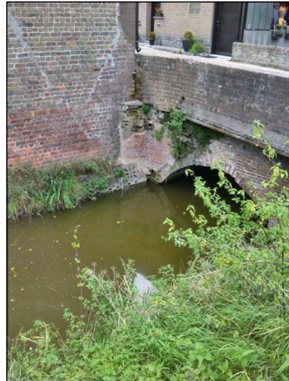
Figuur 18: Herstelde brug.
