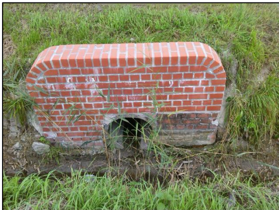
Figuur 23: Kopmuur hersteld in 2017.
