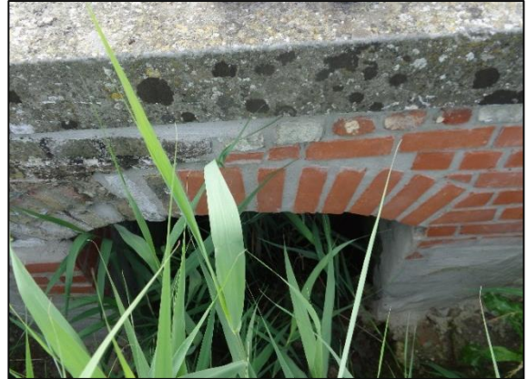
Figuur 22: Herstel kopmuur Westernieuwweg Noord.
