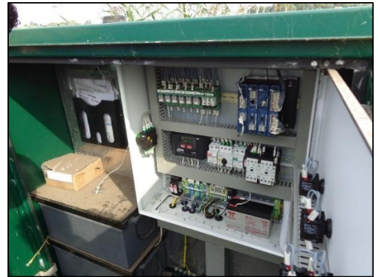
Figuur 32: Plaatsen van een meetkast in de bestaande kast van de stuw 'Moerzwin' en plaatsen van nieuwe batterijen
