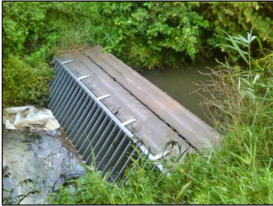
Figuur 24: Rooster om het vuil tegen te houden.
