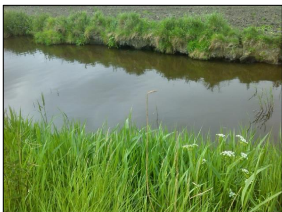
Figuur 11: Steeds verder afkalfende oevers van de waterloop nr. WO.3A.1.
