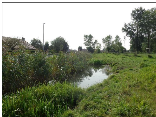
Figuur 12: Situatie voor de werken: afkalvende en onstabiele oevers.
