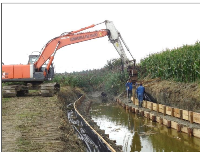
Figuur 9: Plaatsen van houten palen en planken.
