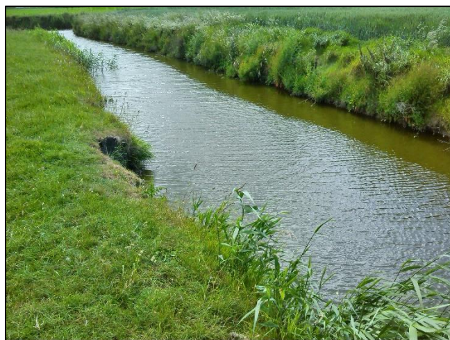
Figuur 8: Situatie voor de werken: afkalvende oever.
