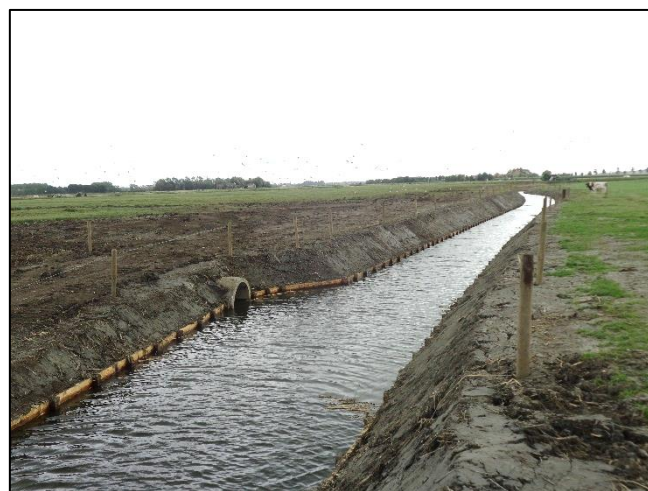
Figuur 10: Inrichting Dorpszwin met getrappt profiel.
