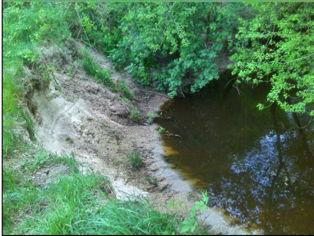
Figuur 15: Situatie voor de werken: sterk afkalvende oever naast landweg.
