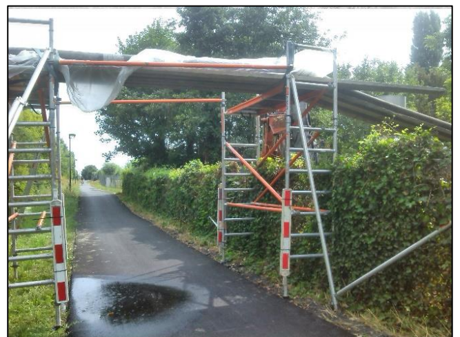
Figuur 20: Overbrugging fietspad voor effluentwater.
