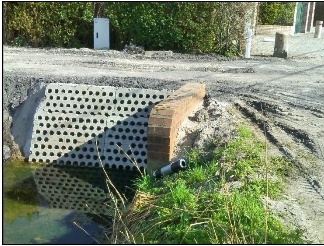
Figuur 23: herstelling kopmuur en aanleg oeverversteving.
