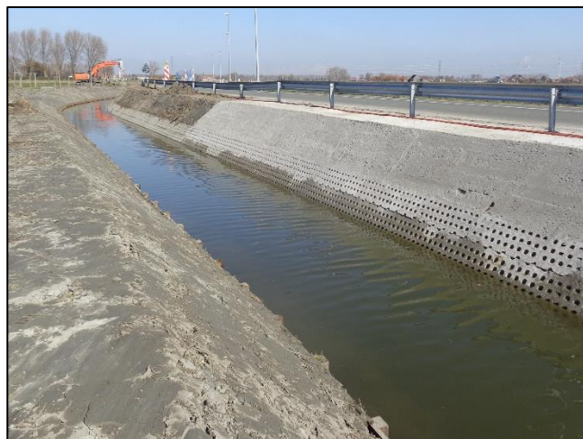
Figuur 14: Inrichting Kruisilader met getrapt profiel aan de kant van de weide en verstevigde oever langs de weg.
