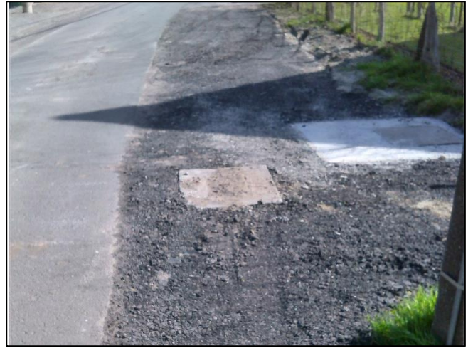
Figuur 24: Heraanleg uitwijkstrook.
