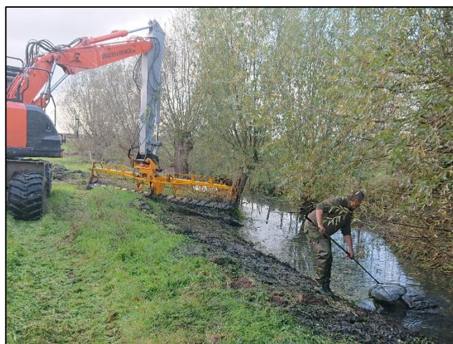
Figuur 2: Machinaal verwijderen van grote waternavel met manuele nazorg.
